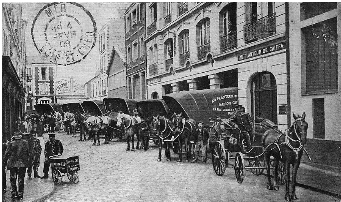
AU PLANTEUR DE CAIFFA, PARIS — Chargement et départ des voitures Service des Expéditions.
